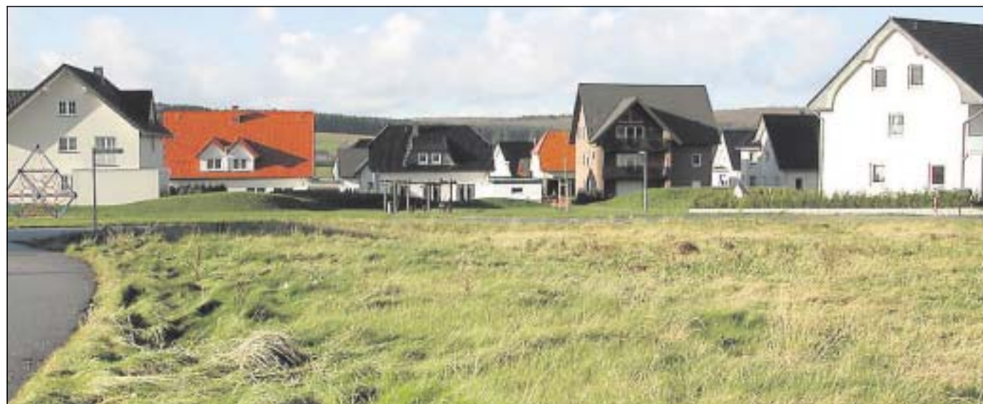
So sieht es aus: Auf der freien Fläche eingangs des Heinrich-Gudemann-Ringes im Warsteiner Baugebiet St.-Poler-Straße III sollen die Roreger-Häuser entstehen. Die Gärten weisen zur hier sichtbaren, bereits bestehenden Bebauung.
